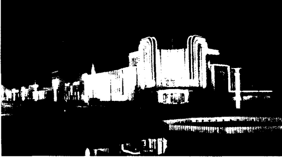
Pavillon pour l'Exposition Universelle de Bruxelles (1935) photo : KIPGEN, Arthur, La participation du Grand-Duché de Luxembourg à l'exposition de Bruxelles, in Le Grand-Duché de Luxembourg , p.206-214.
